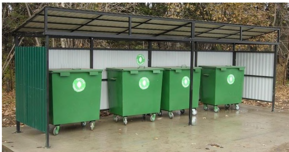
Рисунок 5.14. Контейнерная площадка с навесом на 4 контейнера.
