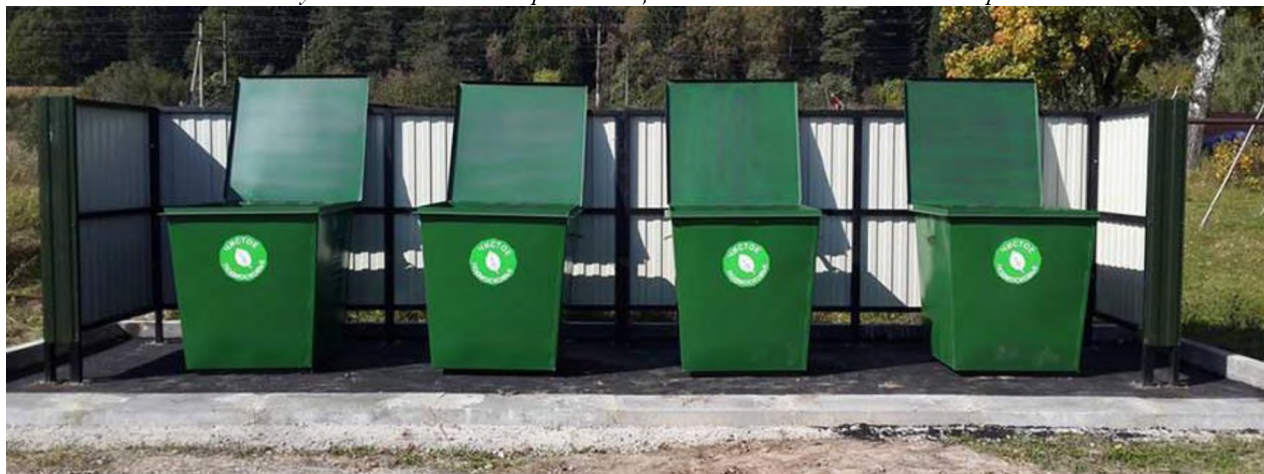
Рисунок 5.15. Контейнерная площадка без навеса на 4 контейнера.
