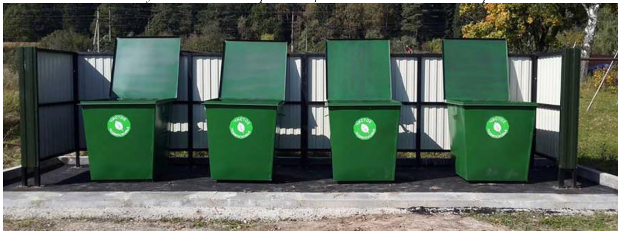
Рисунок 5.15. Контейнерная площадка без навеса на 4 контейнера.
